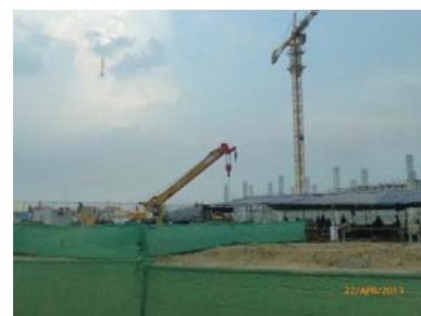
イオンモール建設中
